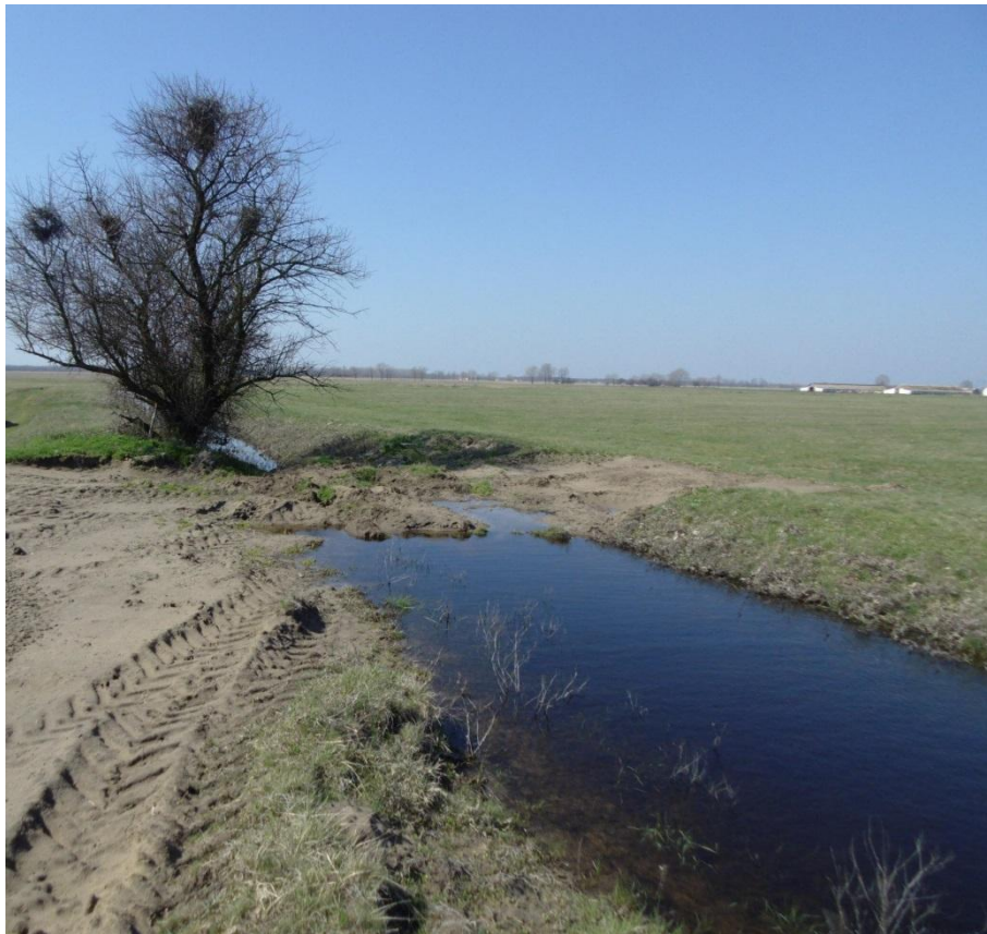
Prilog 8.: Zemljanom branom pregrađeni kanal. Vodoodvodna sposobnost se može značajno ublažiti intervencijom, ali profil korita većinom ostaje intaktno, i na taj način zajednica biljaka i životinja, koja žive na obali i koritu kanala, kao i koncentrovana sposobnost biodiverziteta kanala se jedva oštećuje. Ovu rekonstruktivnu intervenciju smatramo najviše sledivom u Kiškunšagu.
